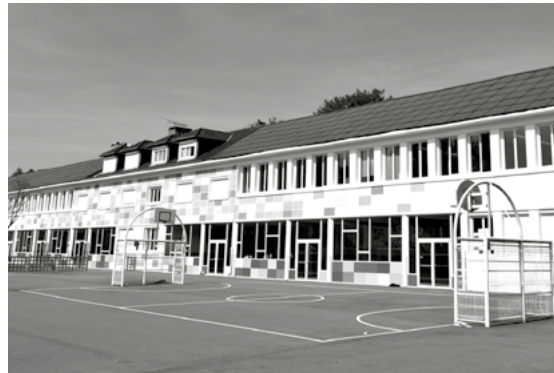
À Malaunay, treize bâtiments municipaux ont été équipés progressivement de panneaux solaires, comme l'école maternelle Olivier-Miannay.
