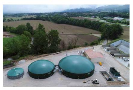
de réglage, nous injectons 55 nM3 de biométhane par heure (sur un potentiel maximum de 70), précise l'agriculteur. La qualité du gaz est parfaitement au rendez-vous, et la quantité aussi, puisque nous produisons un peu plus que ce qui était prévu».
