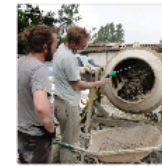
2. Préparer le mélange à l'aide d'une bétonnière.
