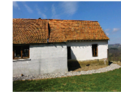
Les deux derniers jours d'accompagnement ont été consacrés à l'isolation de la façade Est.
