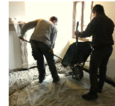
Réalisation de la dalle en juin 2017.
