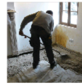
3. Répartir le mélange sur le géotextile (préalablement posé sur le hérisson de galets).
