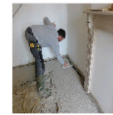
4. Régler la dalle avec un règle de maçon puis taloches.
