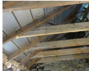
Charpente remaniée en 1907, composée de planches formant les fermettes.
