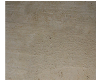
5. Aspect après séchage. La dalle sera recouverte d'un plancher en bois (des carrés de terre cuite hourdés au mortier de chaux pourraient être également posés).
