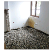
1. Réaliser un hérisson de galets ventilés.
