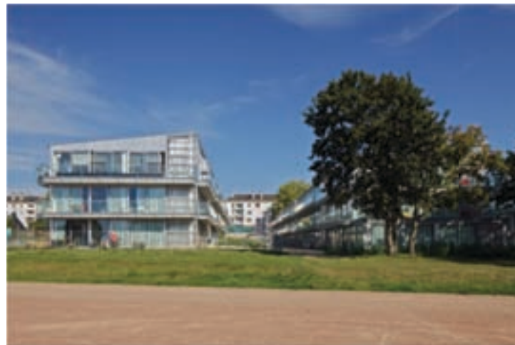
53 habitations HLM, Saint-Nazaire Architectes : Lacaton & Vassal Photographe : Philippe Ruault
