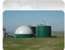
Technique mise en place : voie liquide infiniment mélangé
