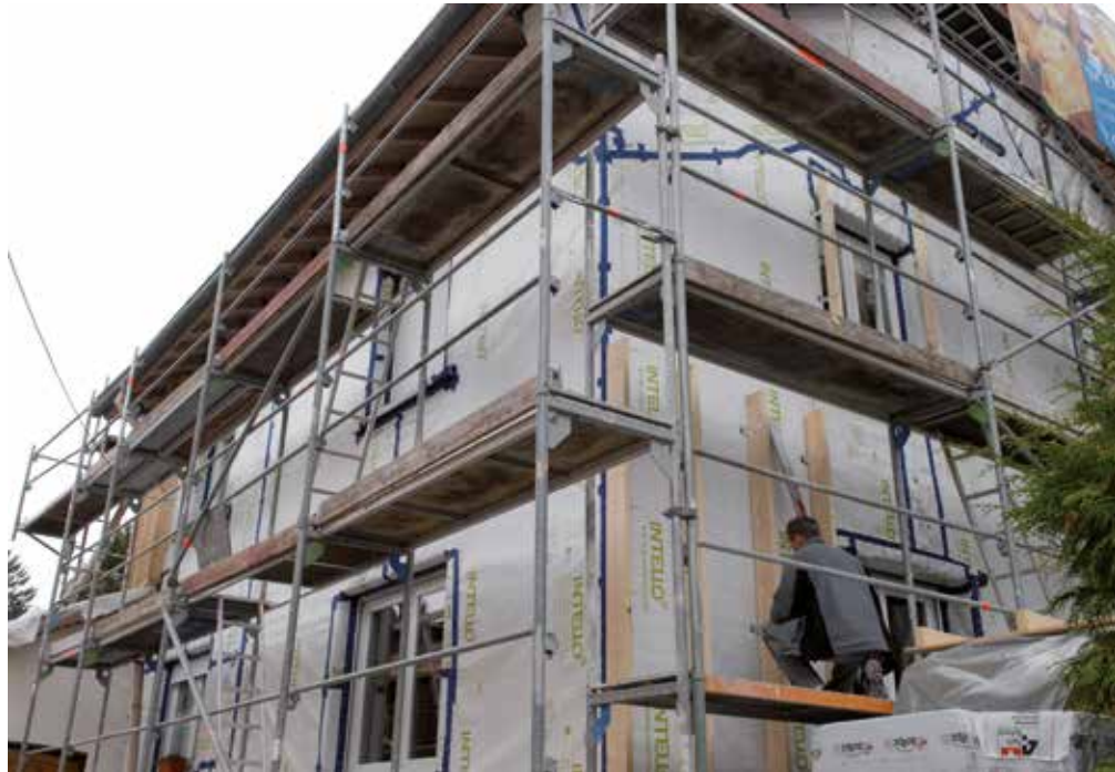
LA RÉGLEMENTATION DOIT ORIENTER LES PROJETS DE RÉNOVATION VERS DES EXIGENCES DE PERFORMANCE GLOBALE
