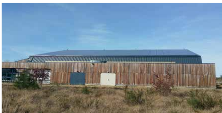
Toiture photovoltaïque sur le gymnase de Labouheyre
