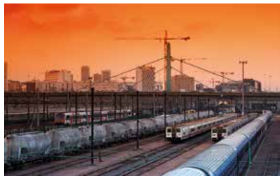
EN RÉGION ILE-DE-FRANCE, DE NOUVEAUX EMPLOIS SERONT CRÉÉS DANS LE SECTEUR DES TRANSPORTS EN COMMUN
